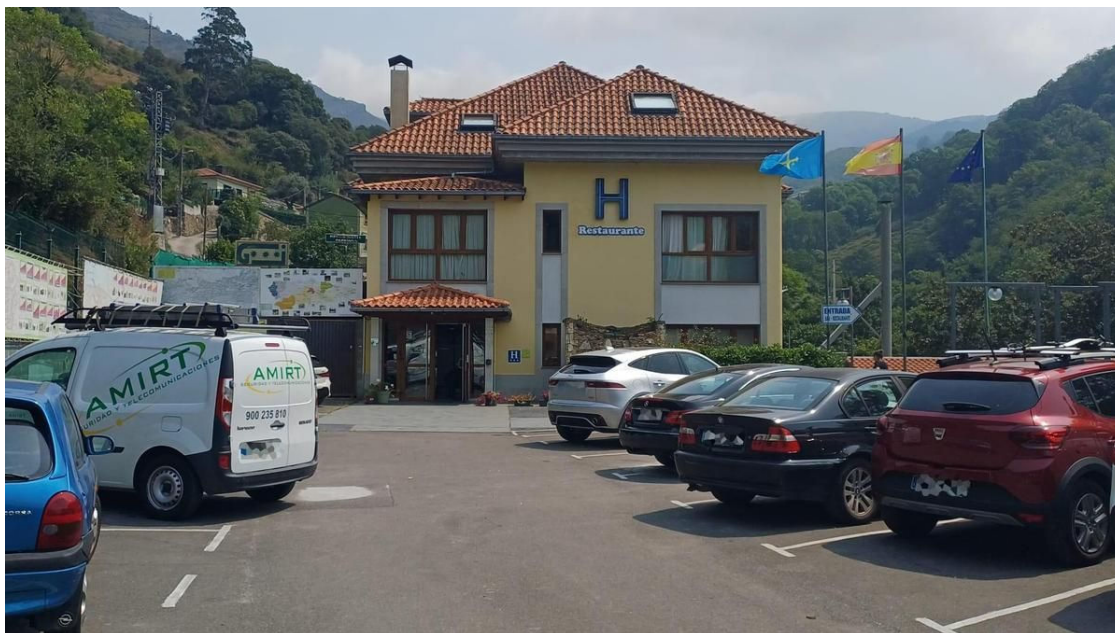
El hotel de Santa Cristina de Lena, uno de los grandes afectados de los cortes de agua / LNE
